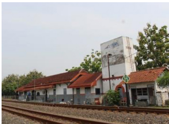
Gambar 3. Stasiun Losari (Lama), lengkap dengan Menara Air untuk mengisi Air Lokomotif (Dok. Balar Jawa Barat, 2018)
