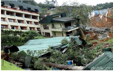
Gambar 5. Bangunan yang tertimbun longsor di kawasan Puncak Pas, Cianjur, Jawa Barat (Sumber: detik.com – 2018).
