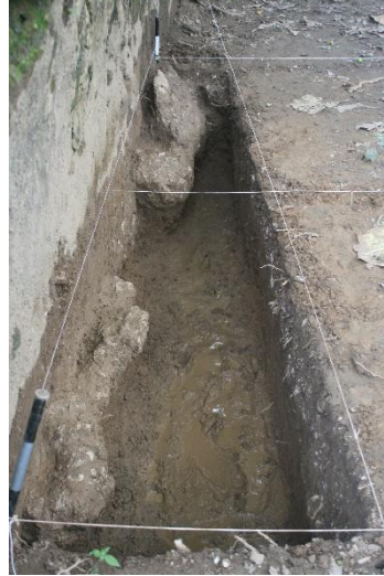
Gambar 3. Perkuatan bangunan benteng menggunakan pondasi yang langsung diletakkan di atas permukaan paleosoil (Sumber: Balai Arkeologi Sulawesi Utara, 2019).
