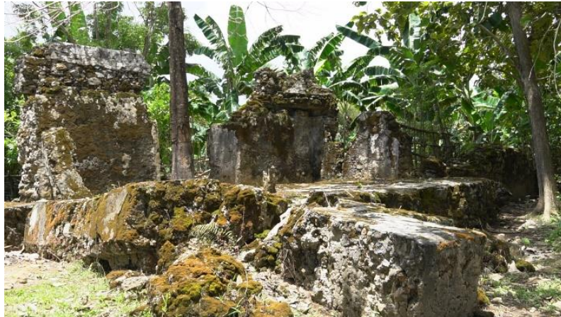
Gambar 2. Dinding bangunan benteng yang roboh (Sumber: Balai Arkeologi Sulawesi Utara, 2019).
